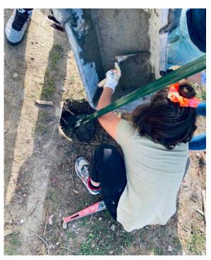
Les groupes de deux passent à l'action et coulent le béton, positionne le poteau et attendent la prise
